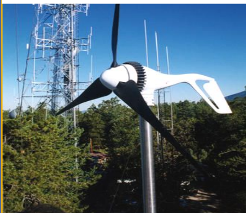
Электроэнергия для телекоммуникационной башни, Аризона, США
