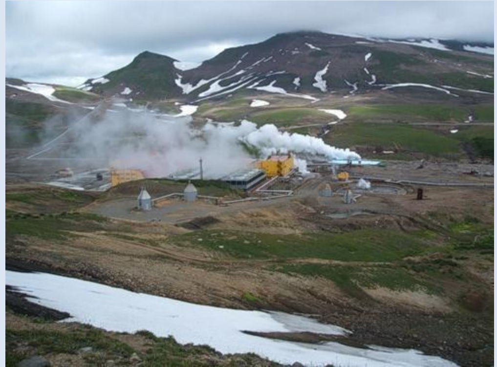
Мутновская геотермальная станция
