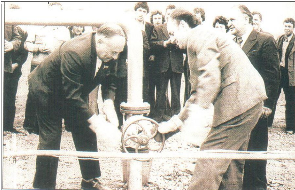
Открытие задвижки на первой скважине Ельниковского месторождения
