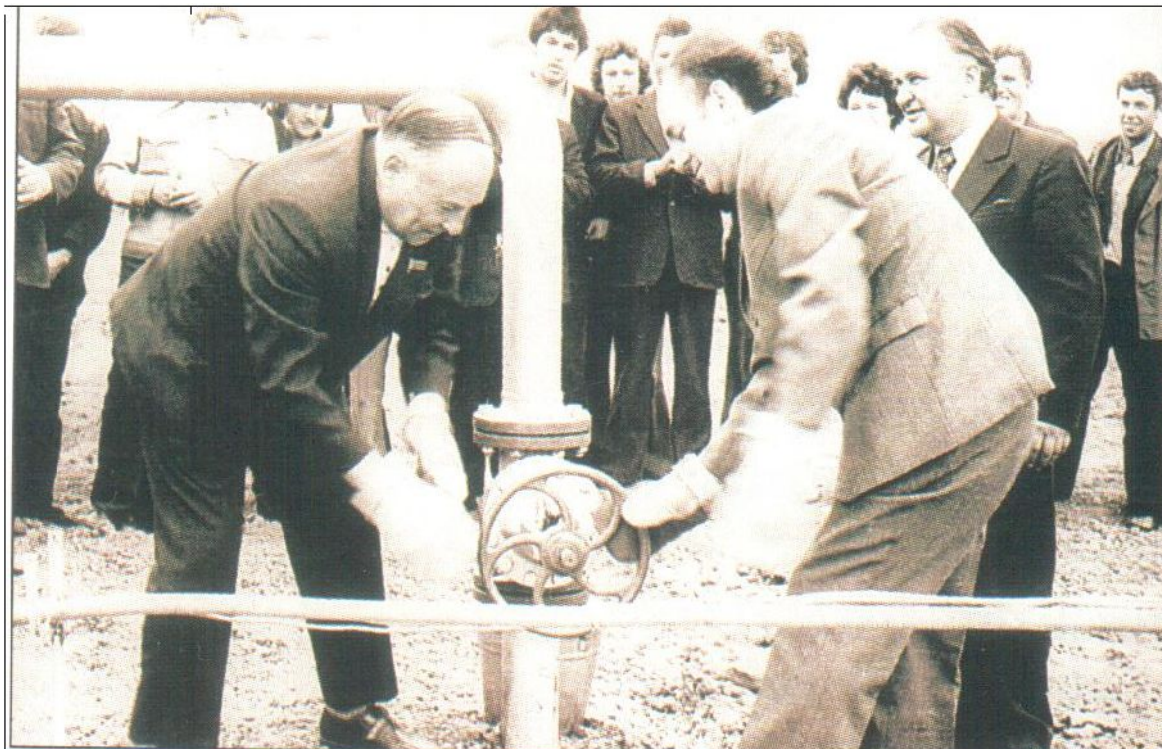
Открытие задвижки на первой скважине Ельниковского месторождения
