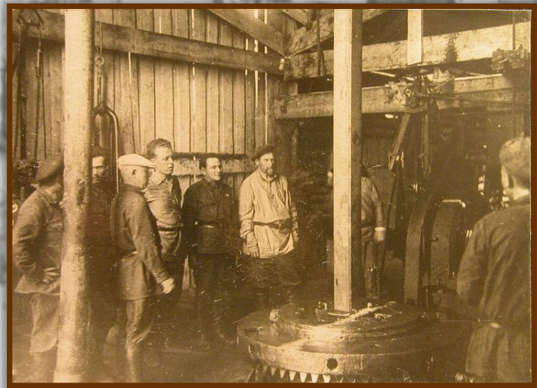
Ведение роторного бурения в Ухто-Печорском тресте
