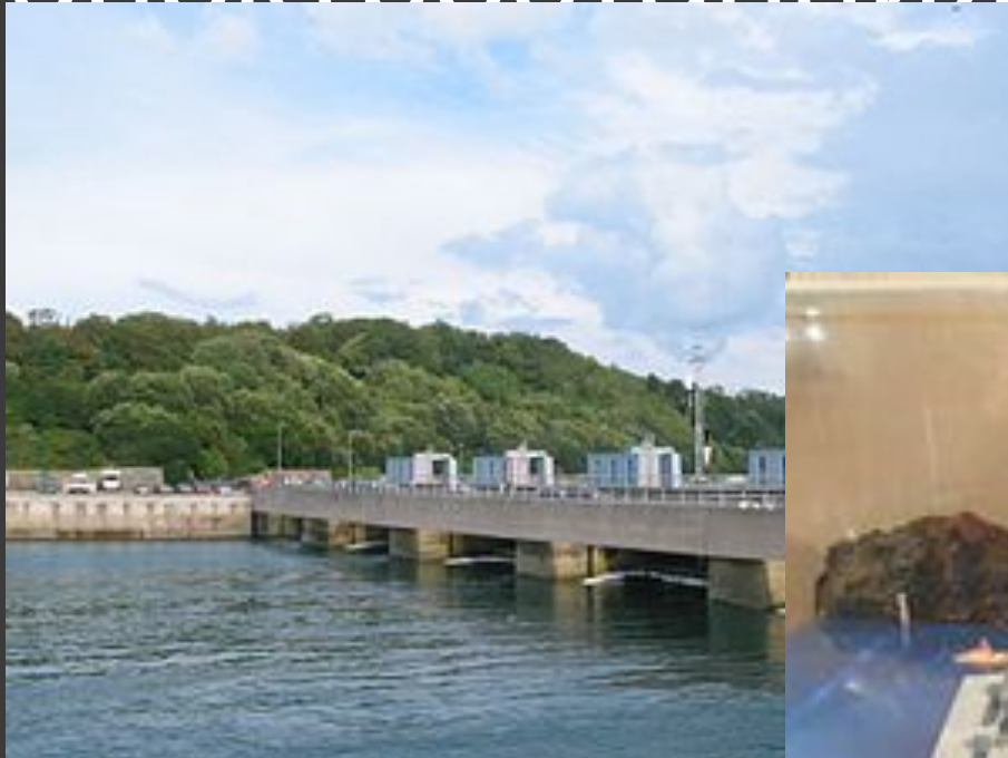
Крупнейшая в Европе приливная электростанция Ля Ранс, Франция
