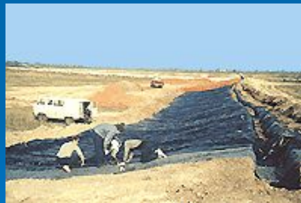
Укладка противофильтрационного слоя
