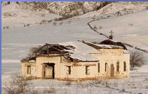
Полуразрушенная Баян-Хосунская церковь
