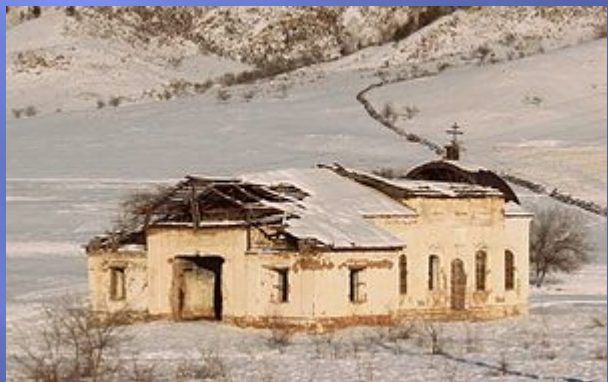
Полуразрушенная Баян-Хосунская церковь
