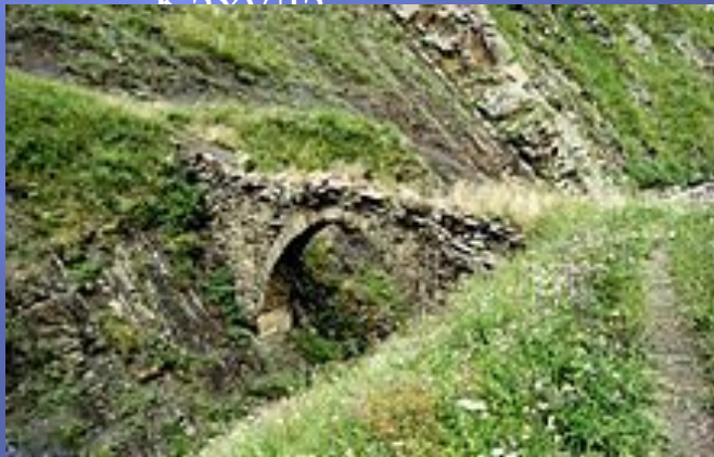
Мост выше Кахула
