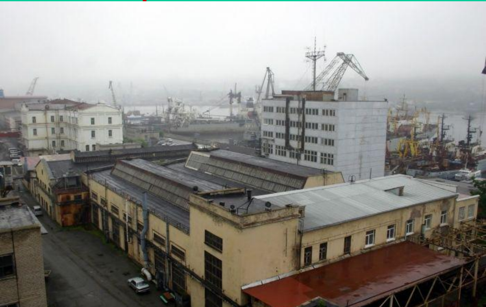
Судоремонтные мастерские (Дальзавод).
