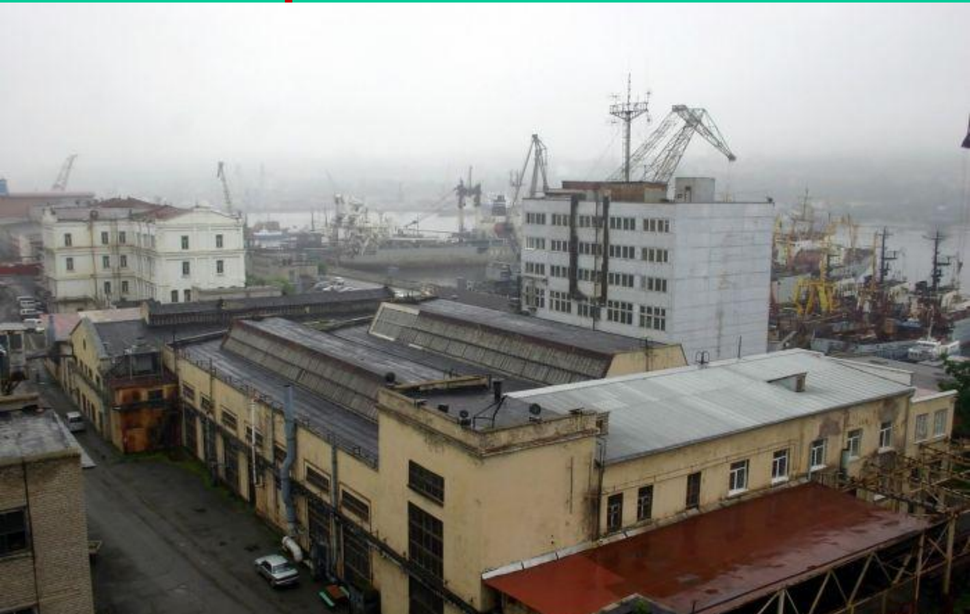
Судоремонтные мастерские (Дальзавод).
