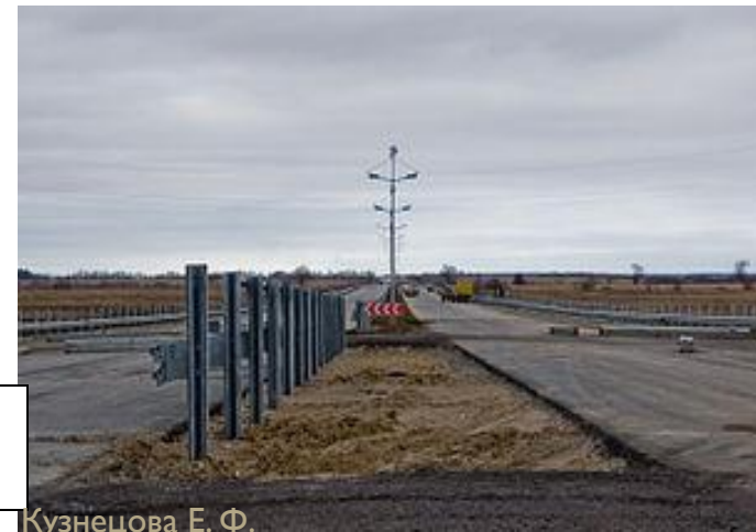
Рис. 10. Участок строящейся трассы « Приморское кольцо » рядом с аэропортом Храброво
