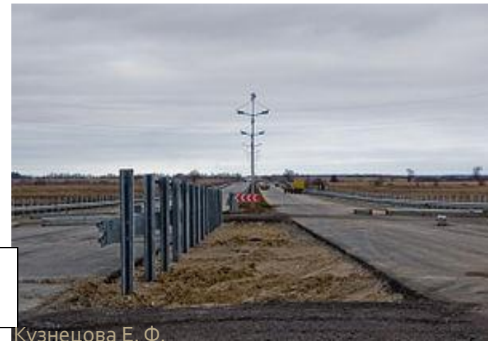
Рис. 10. Участок строящейся трассы « Приморское кольцо »
