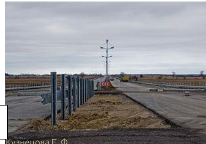
Рис. 10. Участок строящейся трассы « Приморское кольцо »
