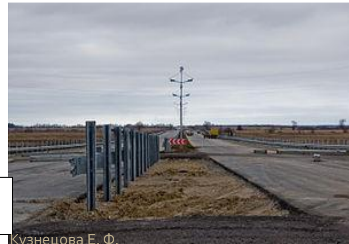
Рис. 10. Участок строящейся трассы « Приморское кольцо »
