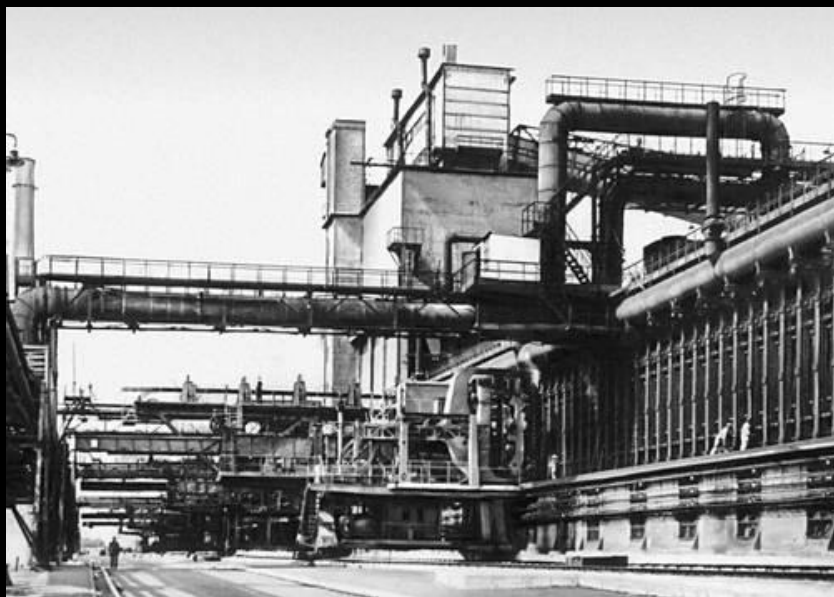
Батарея коксовых печей со стороны коксовыталькивателя
