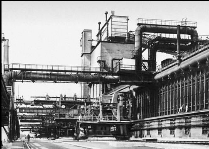
Батарея коксовых печей со стороны коксовиталкивателя
