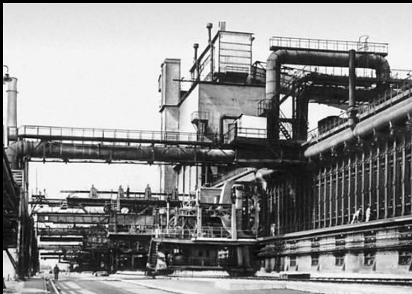
Батарея коксовых печей со стороны коксовыталькивателя
