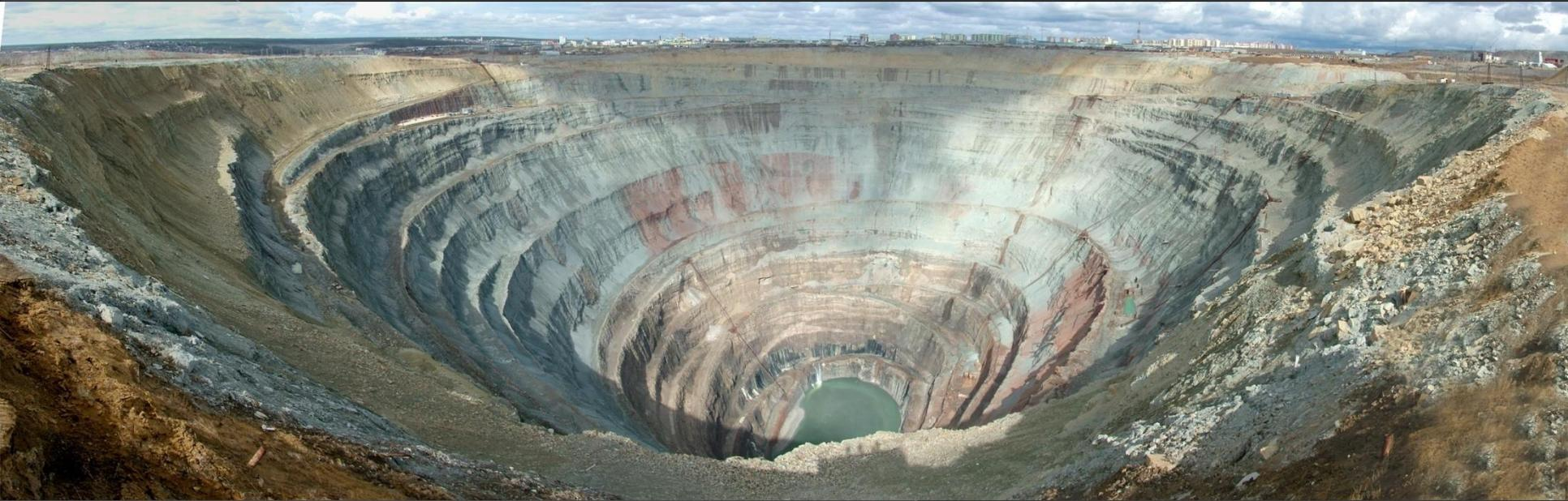
Кимберлитовая трубка алмазного карьера «Мир», рядом с которым вырос город Мирный: глубина - 525 м, верхний диаметр 1200 - 1100 м, нижний 50 - 210 м. На глубину залегания алмазной руды в 1, 2 км ведет спиральный съезд длиной в 7,5 км. С 01.05.2001 приказом АК "Алроса" отработка трубки открытым способом прекращен.
