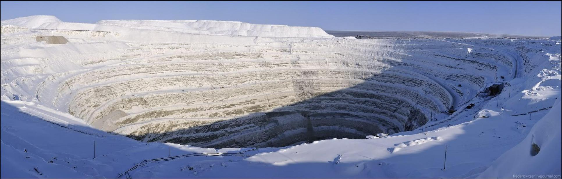
Начало отработки трубки «Удачной» ведет отсчет от 1982 года. Это открытый карьер (один из крупнейших в мире), который уже достиг отметки 530 м. Но такая глубина близка к критической для открытых разработок, и дальнейшая добыча руды возможна преимущественно подземными горными выработками.
