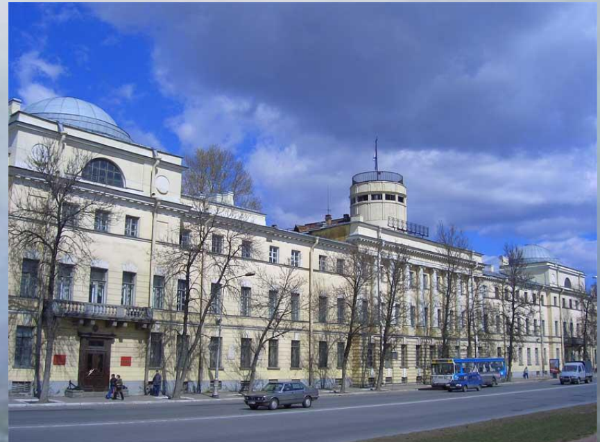
Морской кадетский корпус в Санкт-Петербурге
