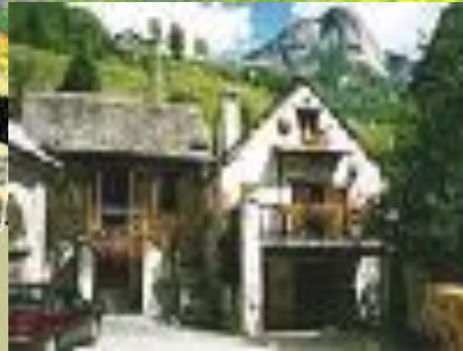
Крыша из каменных гнейс пластин
