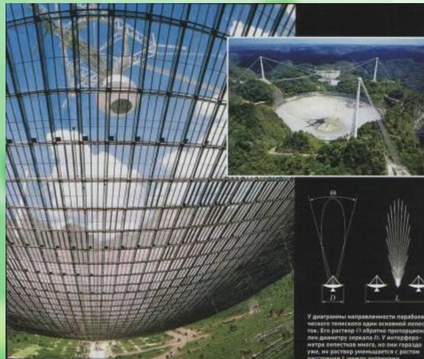
У диаграммы направленности параболического телескопа один основной лепесток. Его размах  $\theta$  обратно пропорционален диаметру зеркала  $D$ . У интерферометра лепестков много, но они гораздо уже, их размах уменьшается с ростом расстояния  $L$  между антеннами.
