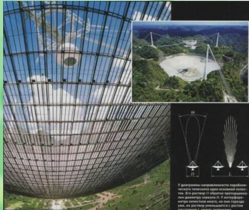
У диаграммы направленности парabolического телескопа один единственный излучатель. Его расфаз  $\Theta$  обратно пропорционален диаметру зеркала  $D$ . У интерферометра лепестков много, но они гораздо уже, и расфаз уменьшается с ростом расстояния  $L$  между антеннами
