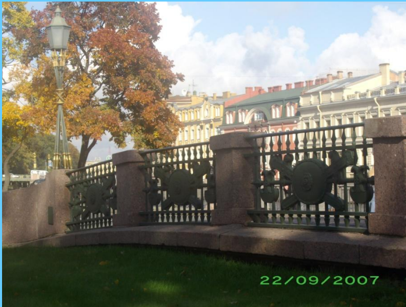
Второй Инженерный МОСТ
