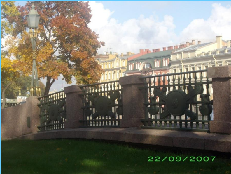
Второй Инженерный МОСТ
