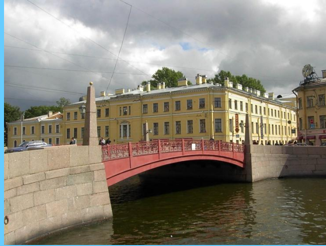
Красный мост 42 м
