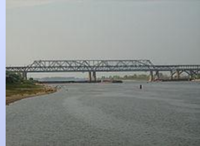
Борский и железнодорожный мост
