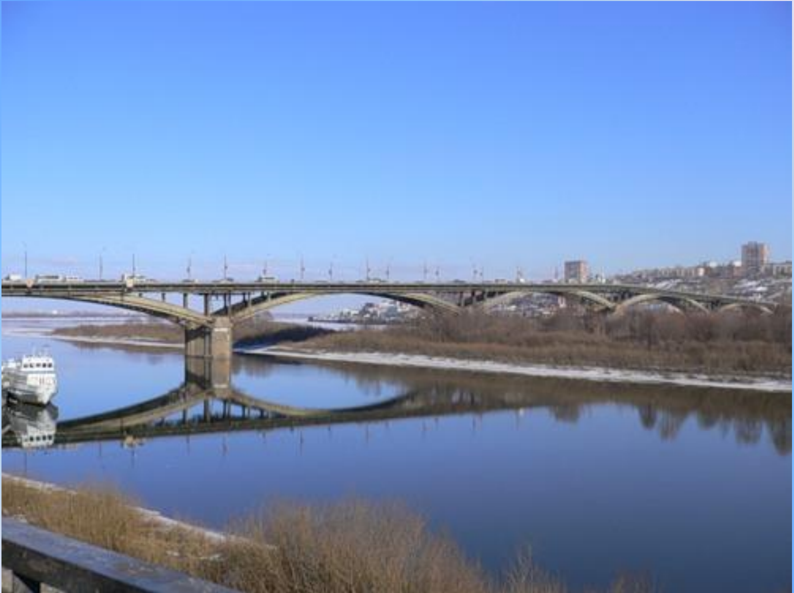
Мост через Волгу и Оку
