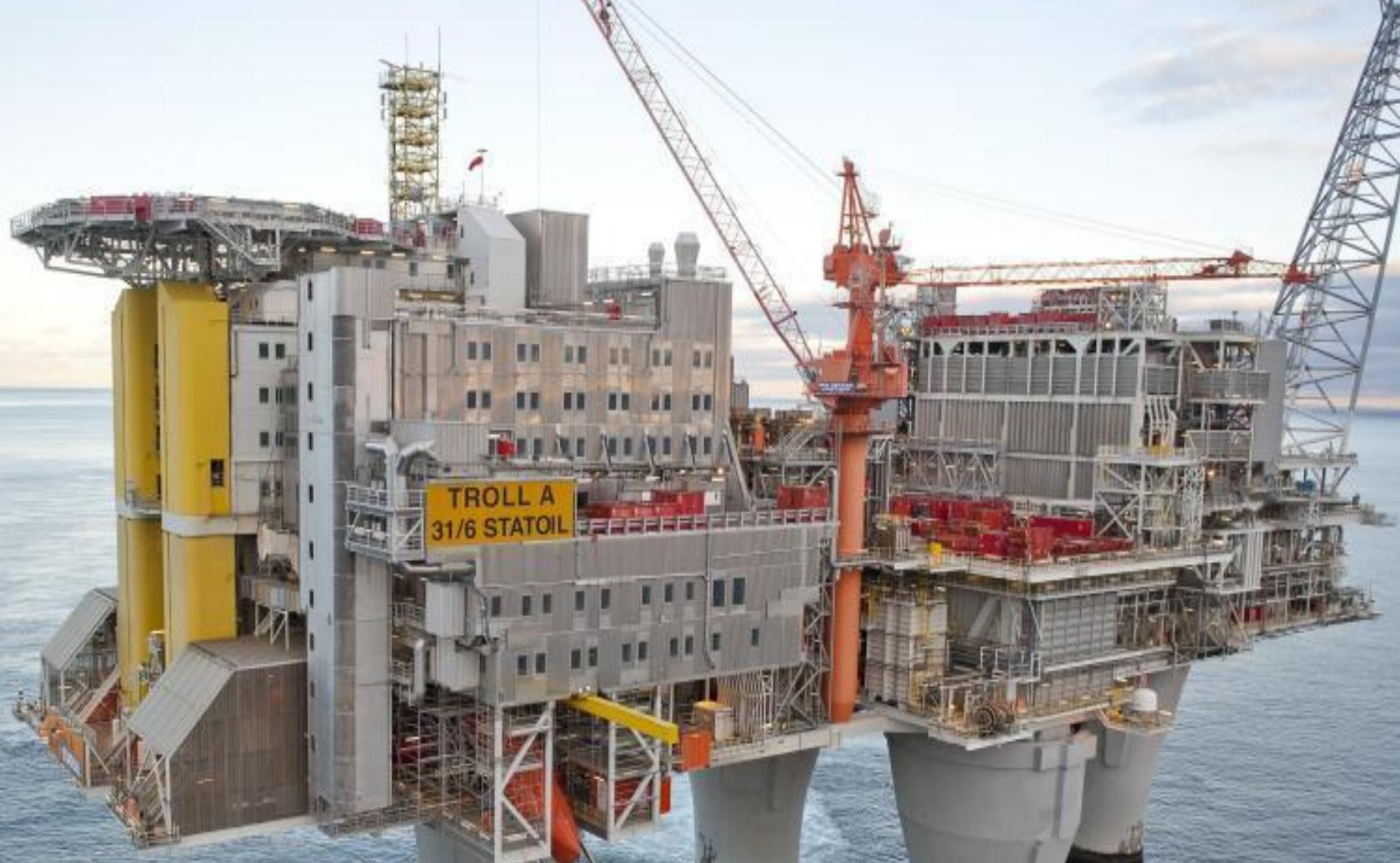
Тролл А – нефтегазодобывающую платформу, считают самым большим объектом, когда либо воздвигнутым людьми. Высота платформы 472 метра, из которых 369 находятся под водой, весит она около 656 миллионов килограмм. Это огромное строение в два раза тяжелее, чем Empire State Building в Нью-Йорке (США).
