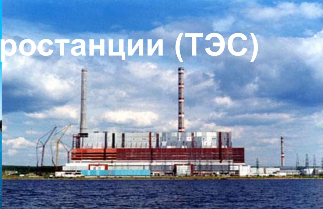
**На тепловых электростанциях механическую энергию получают из внутренней энергии с помощью тепловых двигателей (обычно паровых турбин). Внутренняя энергия выделяется при сжигании нефти, угля или газа.**
