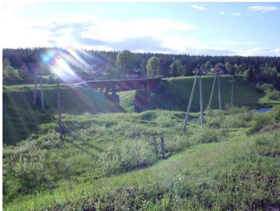
Железнодорожный мост через реку Няндомка.
