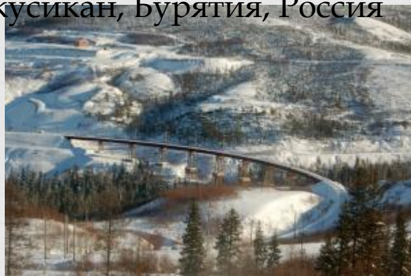
Чертов мост – высокая эстакада на двухъярусных опорах над руслом Итыкита, изогнутая и расположенная в подъеме.
