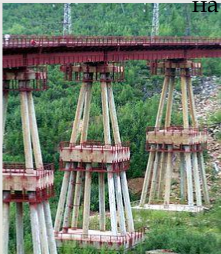
Чертов мост – высокая эстакада на двухъярусных опорах над руслом Итыкита, изогнутая и расположенная в подъеме.
