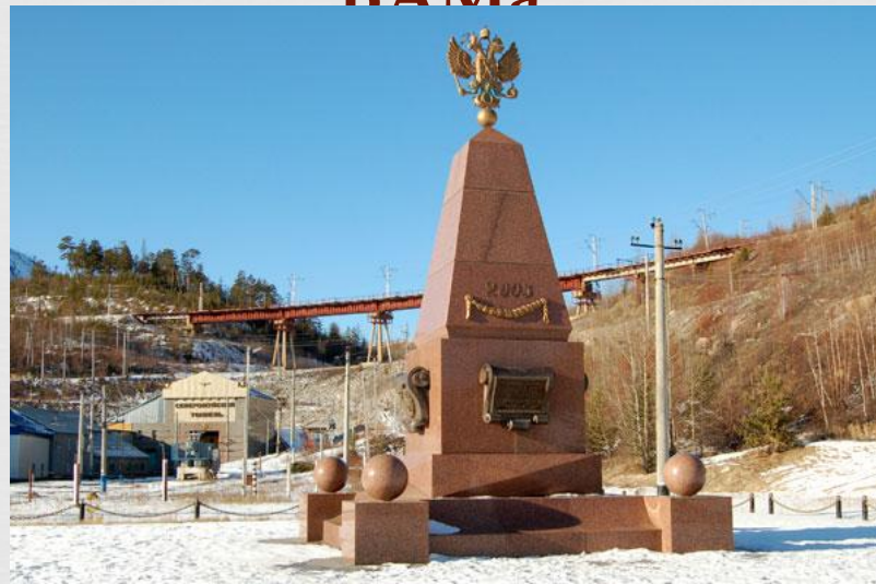
Памятник строителям Северомуйского тоннеля на ст. Окусикан, Бурятия, Россия
