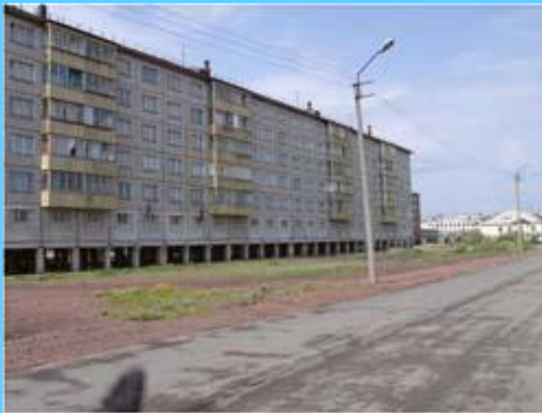
Дома на сваях в Норильске
