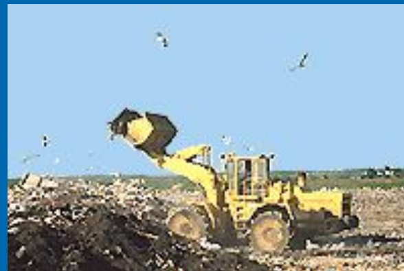
Работы на полигоне
