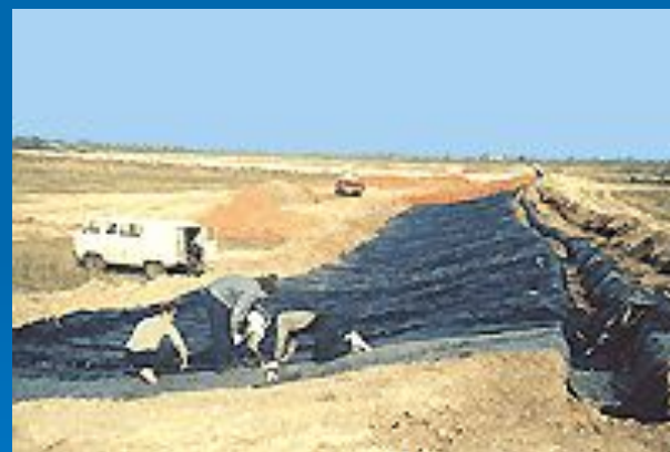
Укладка противофильтрационного слоя
