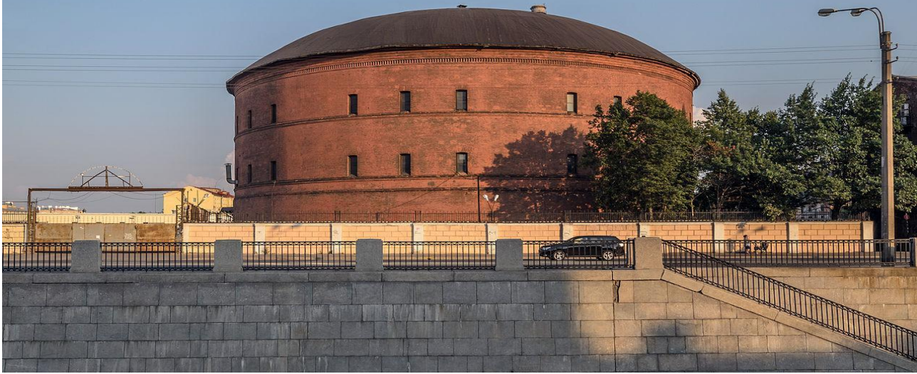
Газгольдер низкого давления (переменного объема)
