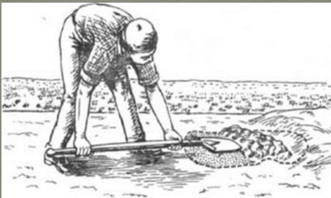
Закладка шурфа. Выемка грунта горизонтальными пластами
