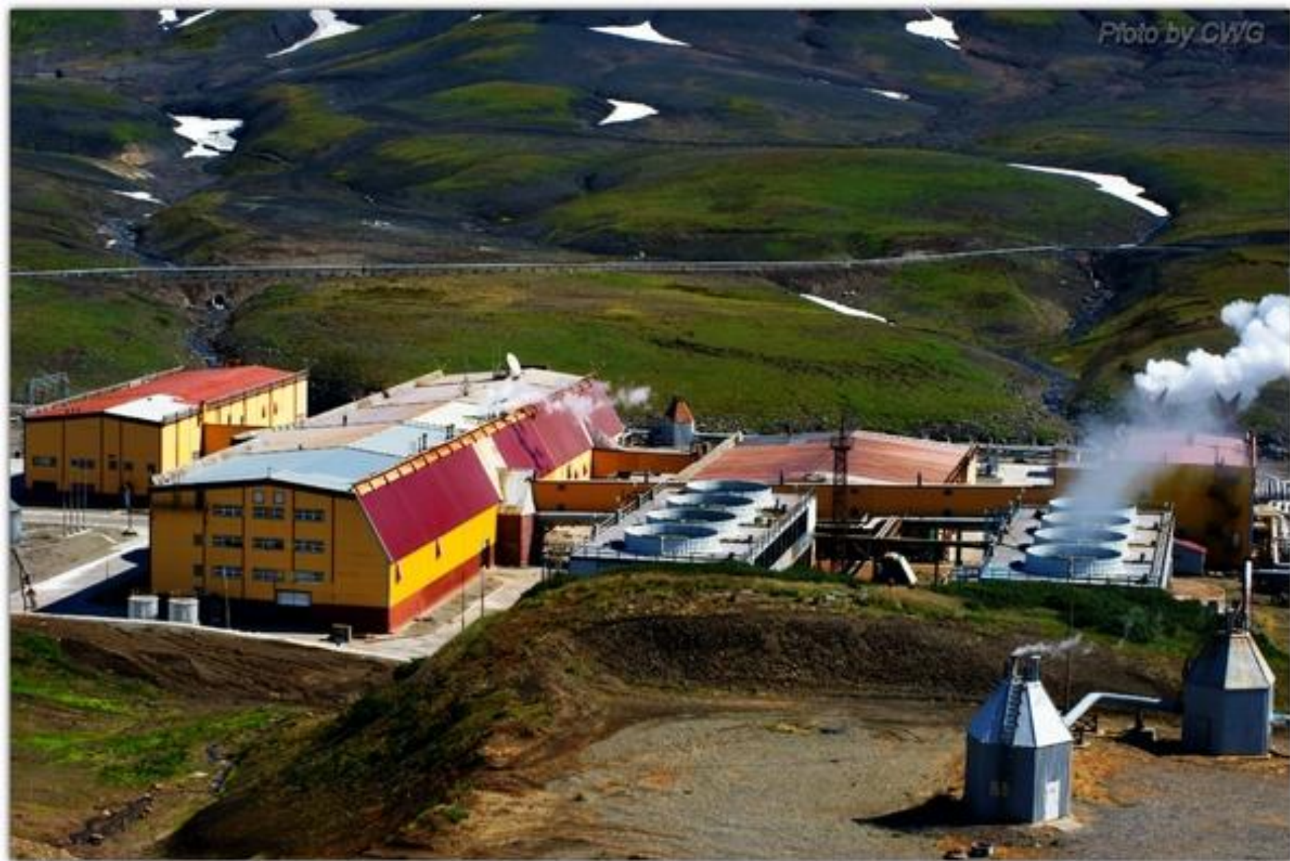
Камчатка - Мутновская Геотермальная электростанция
