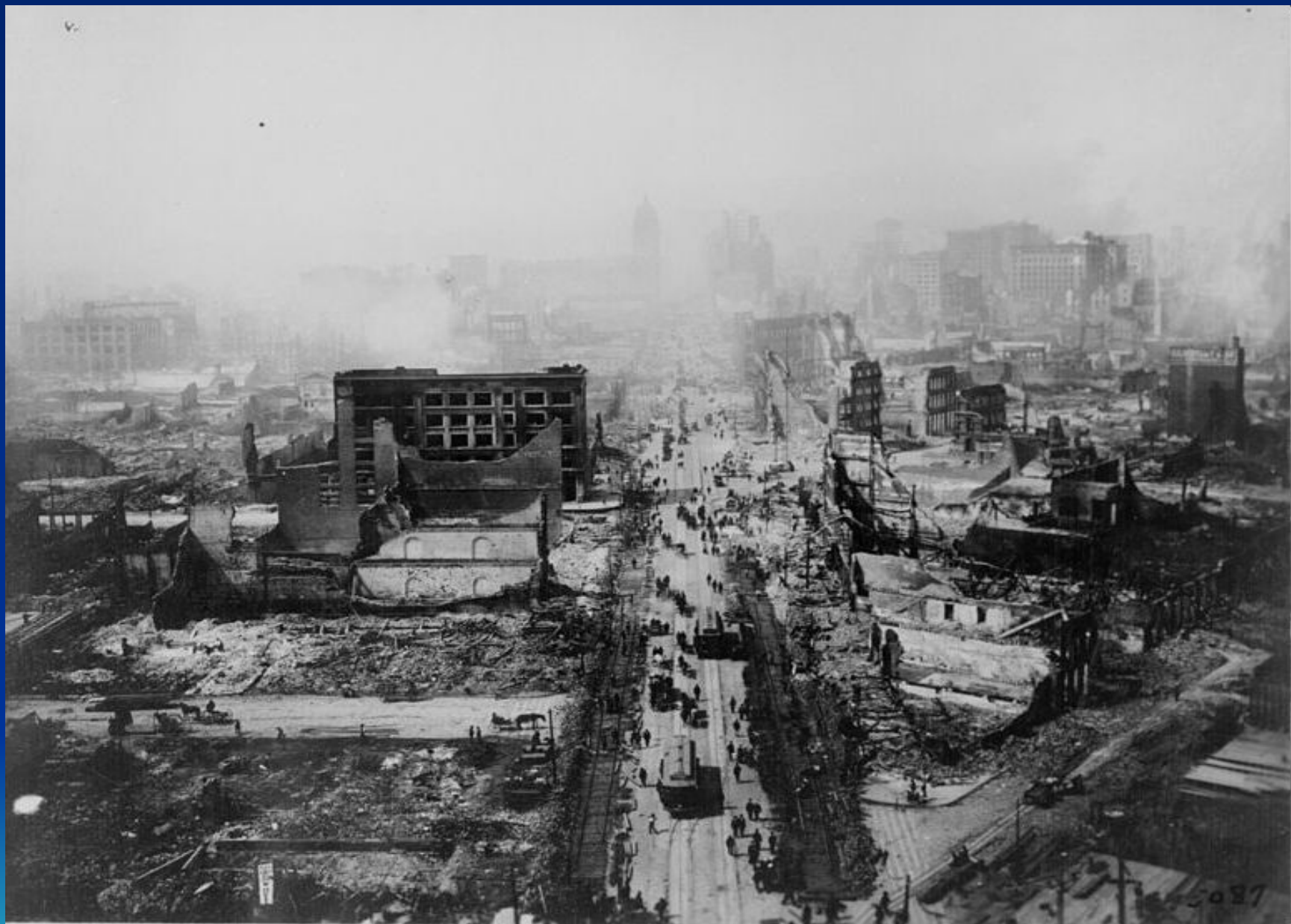
Последствия катастрофического землетрясения в Сан-Франциско, США в 1906 году.
