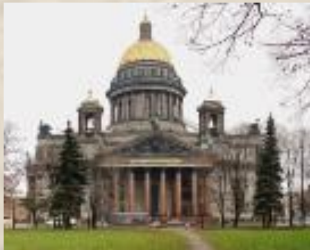
Колонны Исаакиевского собора. Арх. Монферран. Масса колонн – 114 т. Высота собора – 101 м
