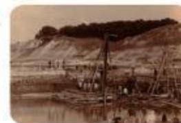
Земляные работы проводились практически полностью вручную. По берегам канала с помощью чугунной "бабки" устанавливали плотины. При помощи блочной системы ее поднимали, затем опускали, чтобы забивать сваи. Шлюзы покрывали деревянными досками из дуба.
