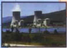
Атомная электростанция во Франции
