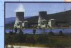
Атомная электростанция во Франции
