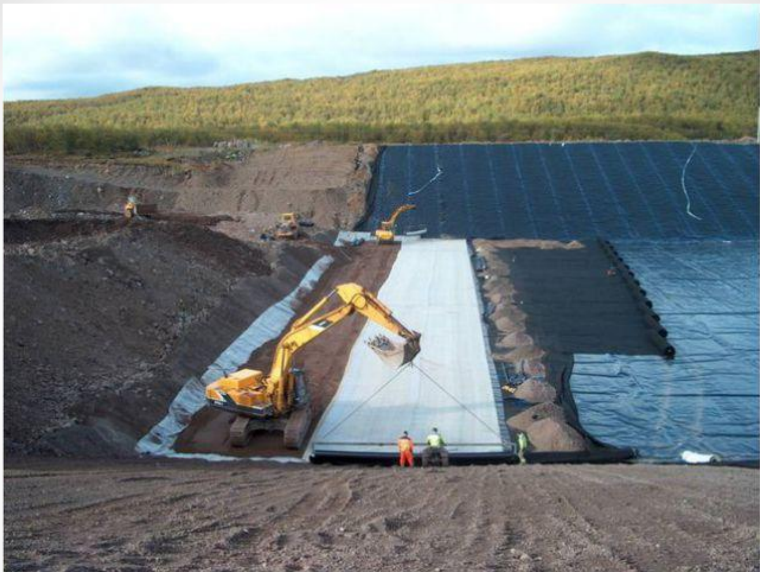
Полигон ТБО «МАГ-1», Нижегородская область. Он предназначен для размещения и обезвреживания твердых бытовых отходов (ТБО) и промышленных отходов (ПО) 3-4 классов опасности. Рассчитан на 15 лет эксплуатации.
