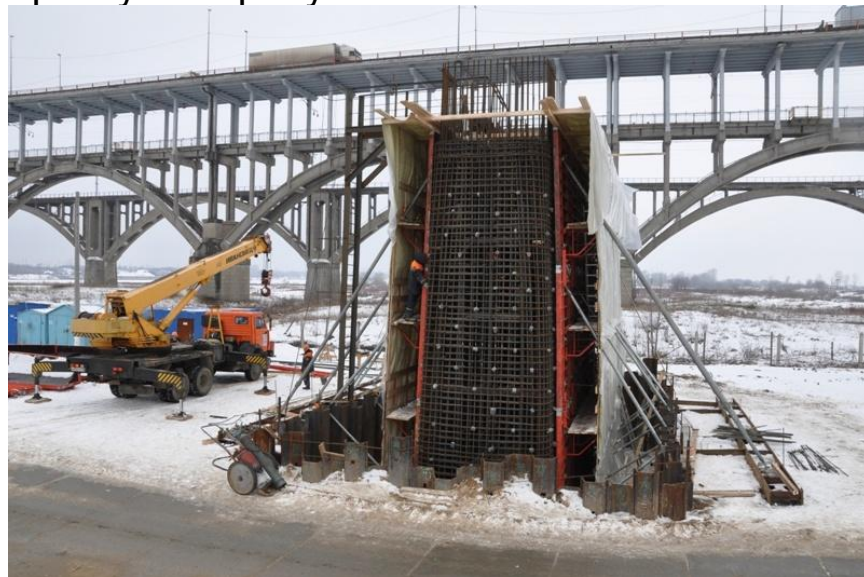
Устройство каркаса массивной части опоры N10 левобережной эстакады
