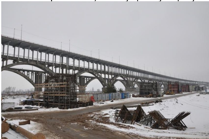
Общий вид левобережной эстакады
