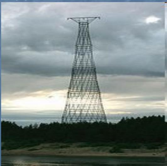
Шуховская башня на Оке — единственная в мире башня такой конструкции. Она имеет гиперболоидное многосекционное строение и является опорой линии электропередачи. Ее высота составляет 128 метров.
