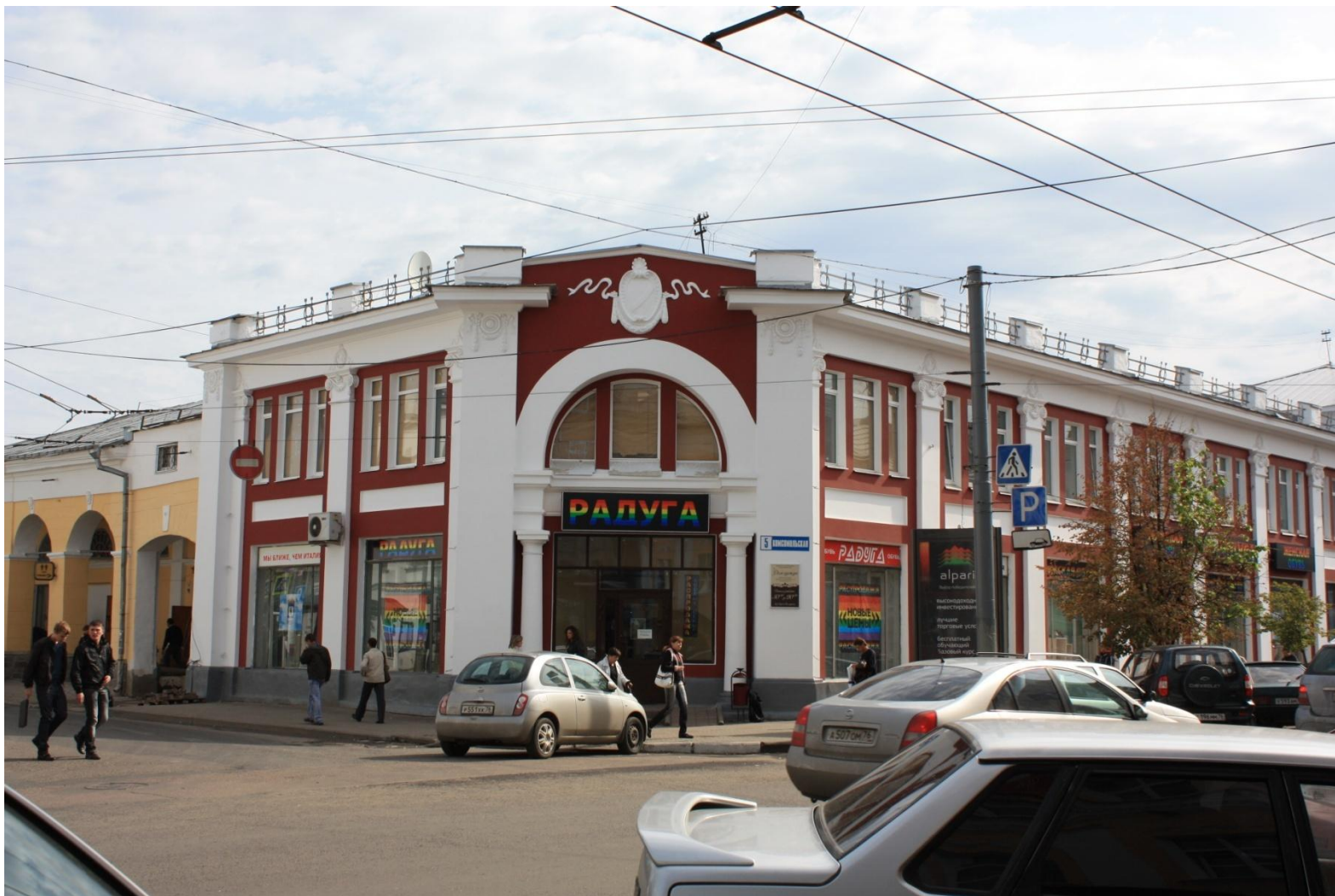
г. Ярославль, ул. Комсомольская, д. 5 «Торговое здание»
