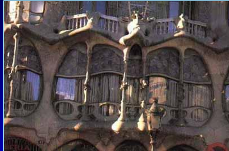
Жилые дома в Барселоне
