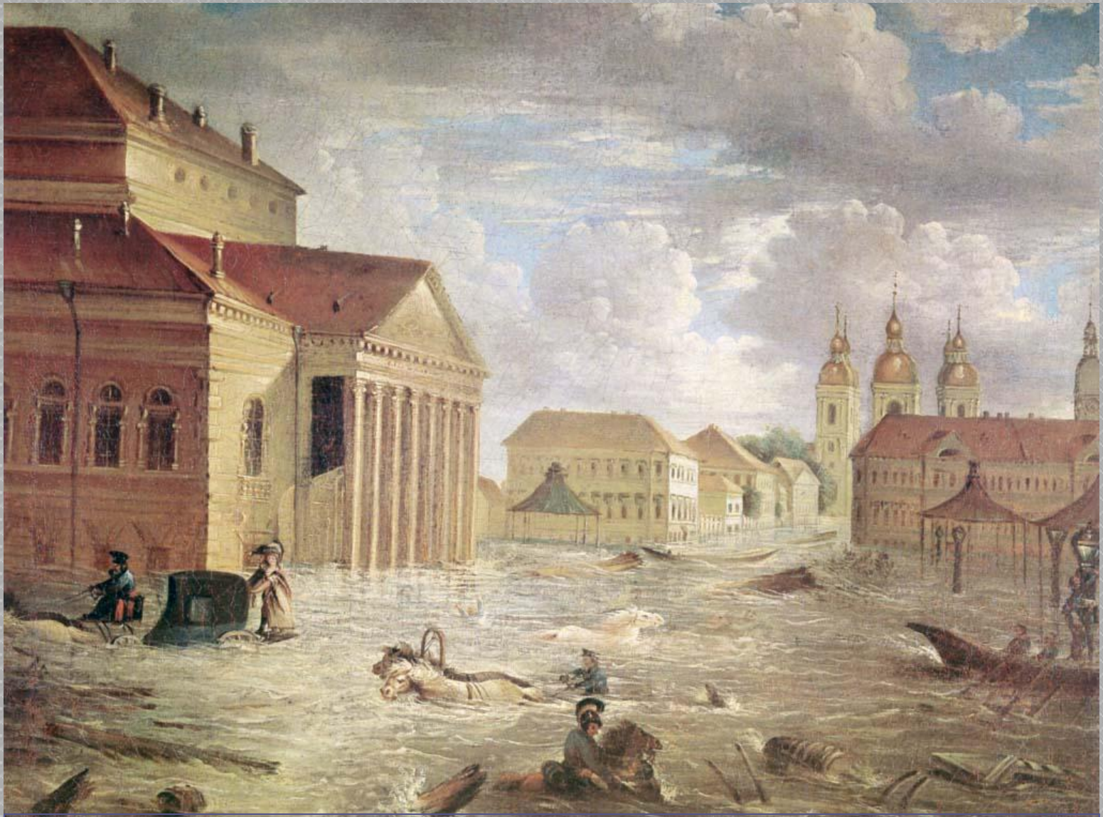
Наводнение в Санкт-Петербурге.
