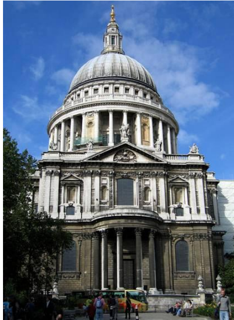
Собор святого Павла, построен в 17 веке по проекту известного Английского архитектора Кристофера Рена.
