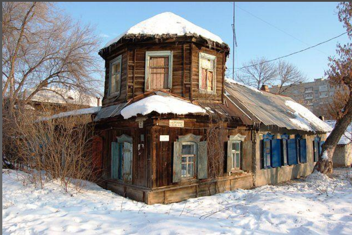
Ул. Царёвская (2 Садовая). Начало XIX века.
