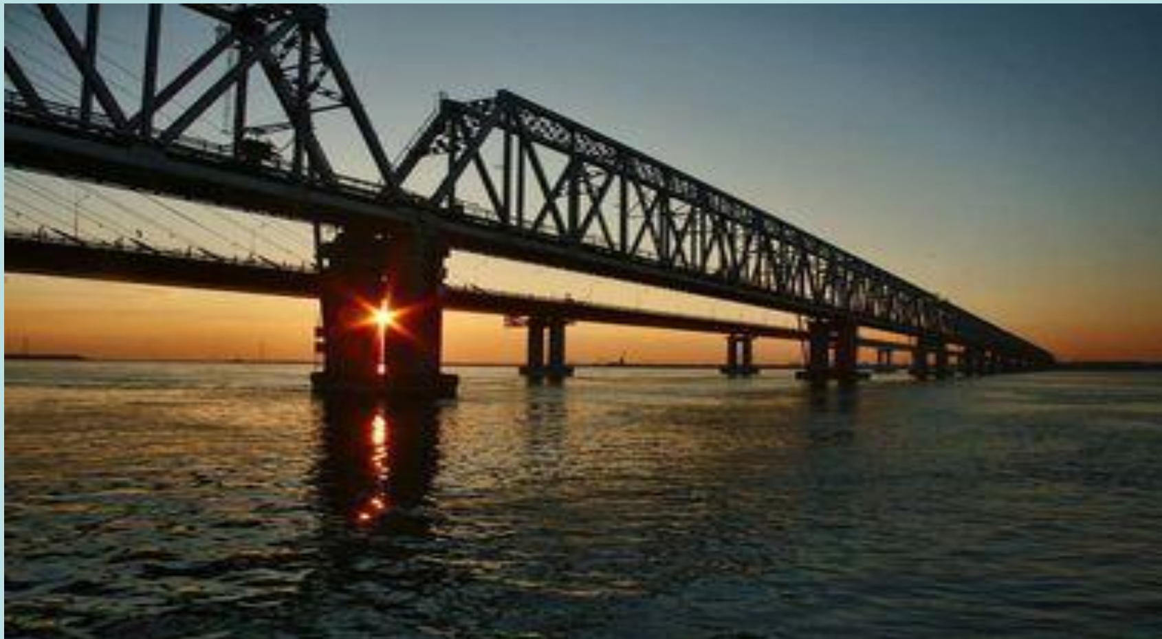
Мост через Обь
