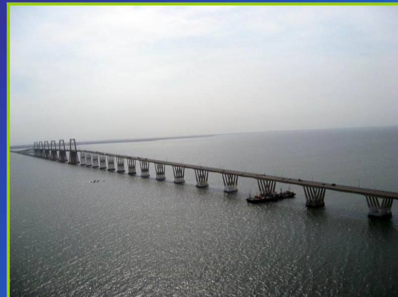
Рис. 43. Мост через Маракайбо
