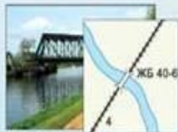
Железная дорога и железобетонный мост
