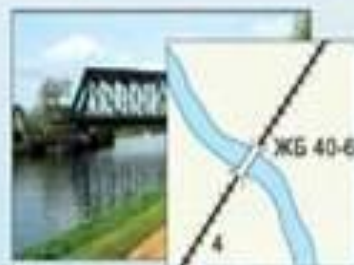
Железная дорога и железобетонный мост
