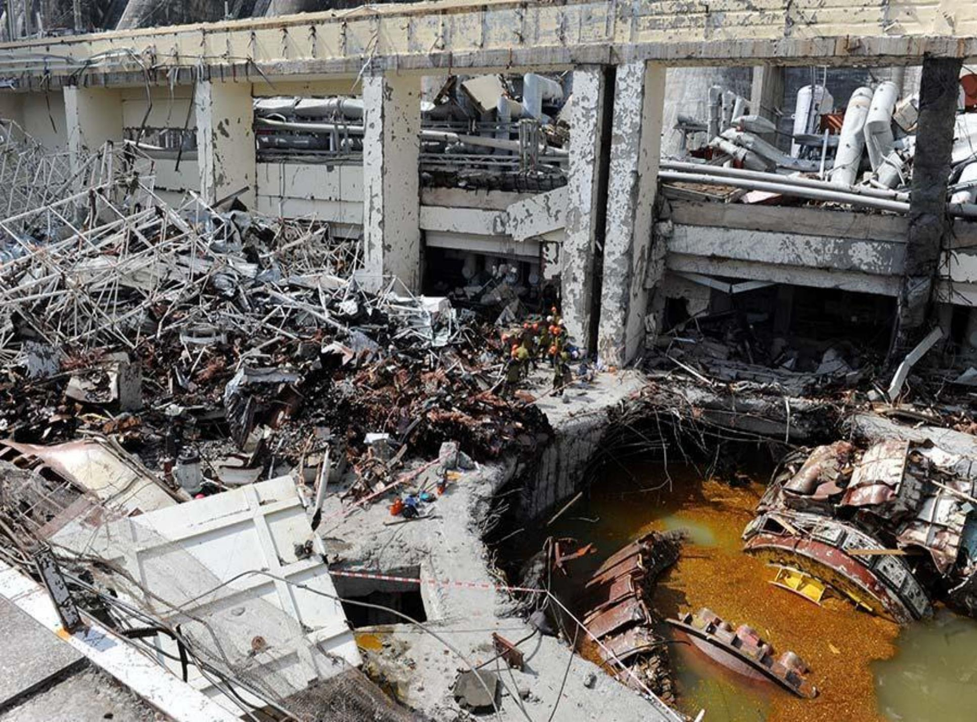
При аварии напором воды была разрушена крыша машинного зала.
